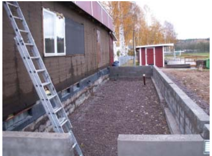
Grunden är gjord, här är färdigt för väggarna
