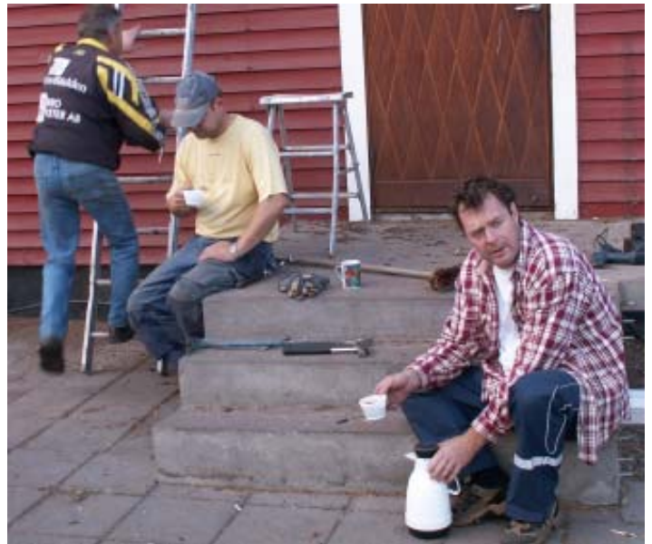
Kafferast vid rivningen av uteplatsen och borttagning av plattor, Kenth Sörman, Stefan Arthursson och Martin Johansson
