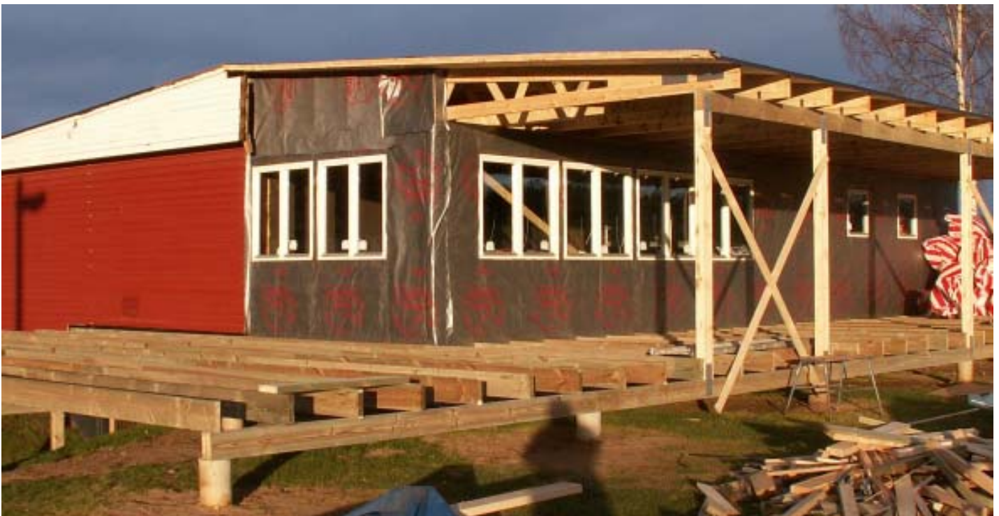
Här är väggar och tak klart och stommen till uteplatsen är gjord. Nu kan man se hur det kommer att bli. Det är inte utan att man längtar till nästa fotbollssäsong. Sture har förresten redan målat panelen, den ligger färdig inne i klubbstugan.
